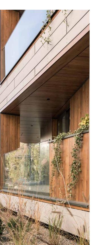
Gli strati di carta kraft e decorativa sono impregnati di resine termoindurenti, essicati e pressati ad alta pressione e ad alte temperature per ottenere un pannello dalle proprietà eccezionali, conforme alla norma europea EN 438.
