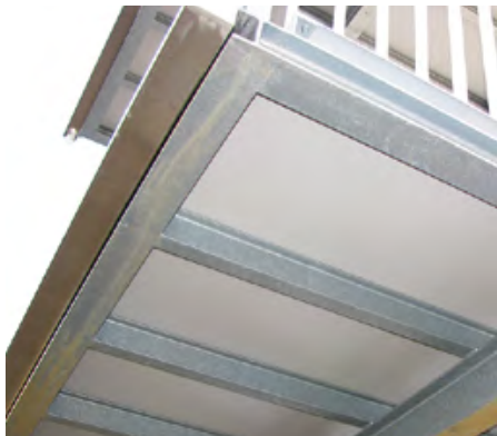
SPODNÍ KONSTRUKCE / NOSÍKY
