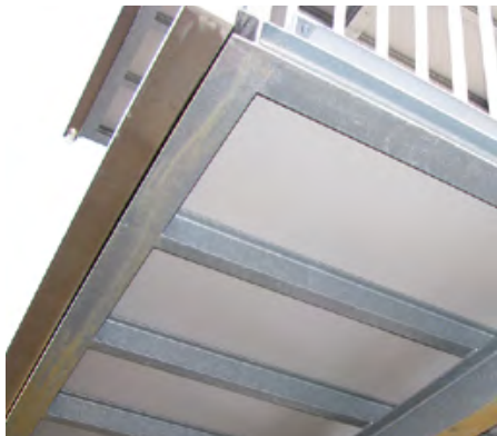
SUBESTRUCTURA/ELEMENTO DE SOPORTE
