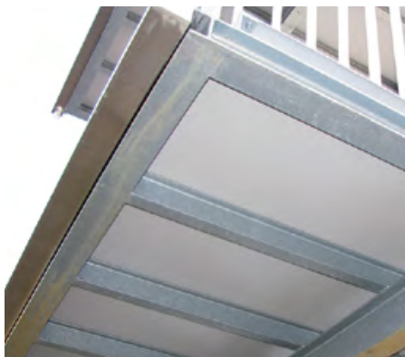
SOUS-CONSTRUCTION / PARTIE PORTEUSE Image 131
