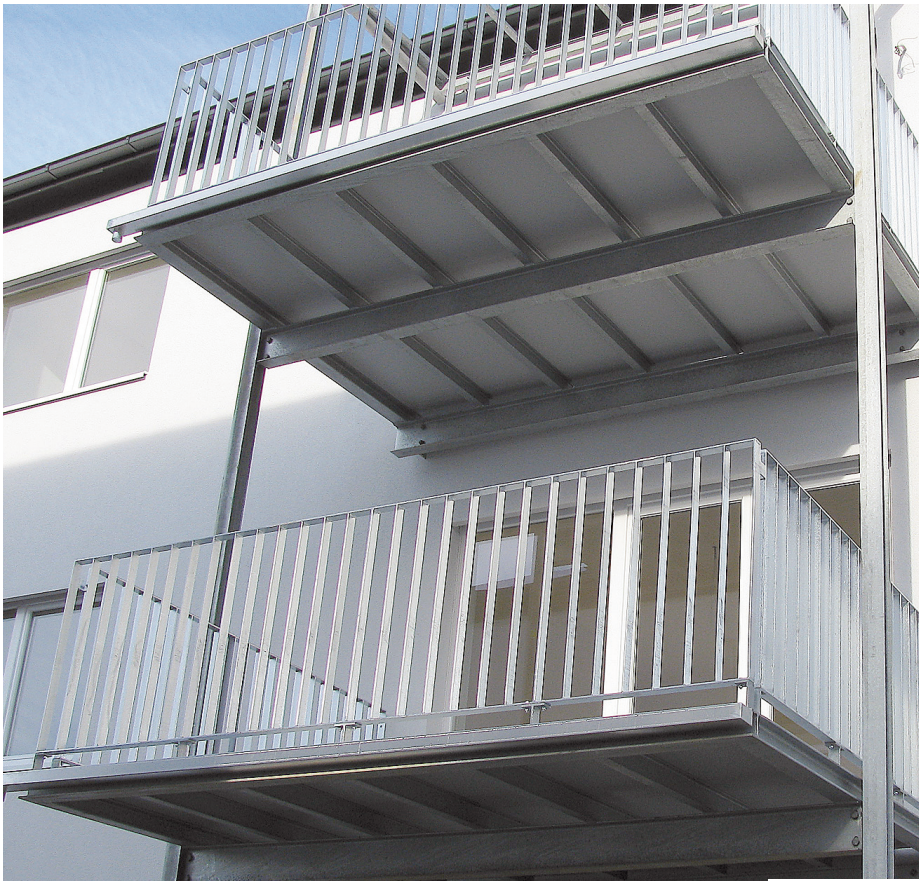
PANNELLO PAVIMENTO BALCONI EDIFICIO ST. VEIT/GLAN, AUSTRIA
