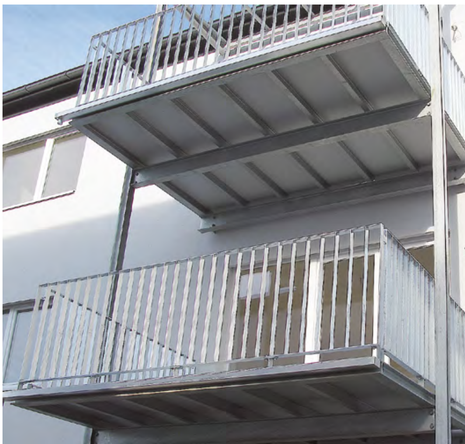
ПАНЕЛЬ ДЛЯ ПОЛОВ НА БАЛКОНАХ, ОБЪЕКТ ST. VEIT/GLAN, АВСТРИЯ
