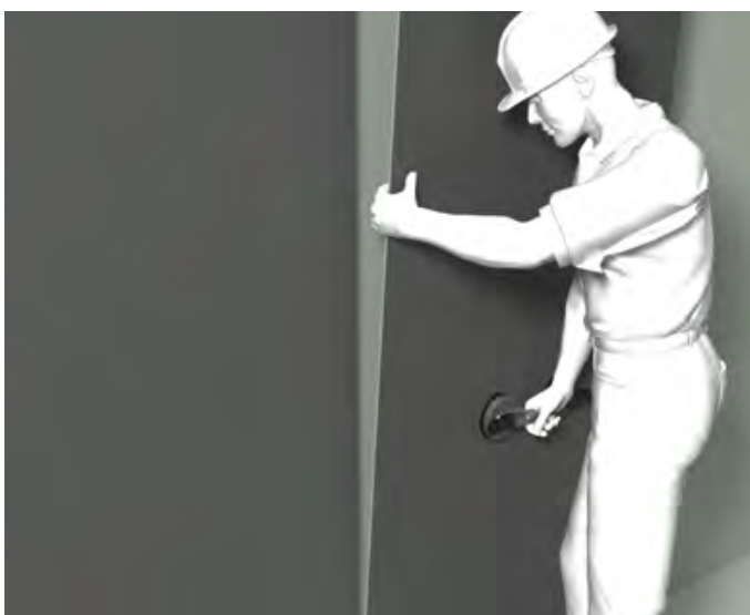
Umístění desky pomocí přísavek
