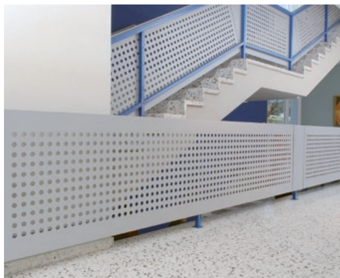
BALUSTRADA SCHODOWA — WYWIERCONE OTWORY
