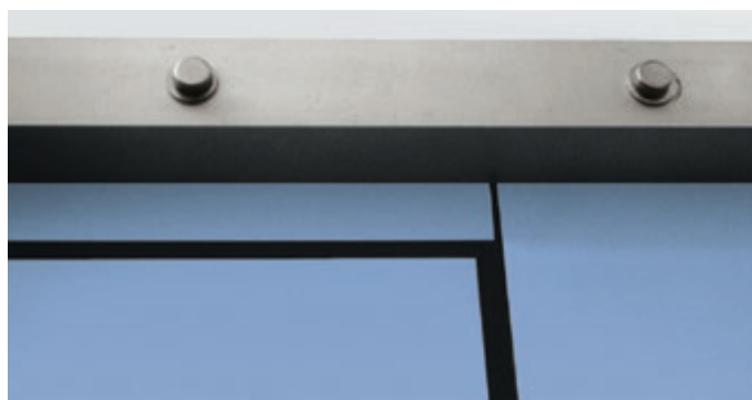
МИНИМАЛЬНАЯ ВЫСОТА ПРОФИЛЯ ДВЕРНОЙ ПЕРЕМЫЧКИ У ДВЕРЕЙ, ОТКРЫВАЮЩИХСЯ ВНУТРЬ, 80 ММ, ЧТОБЫ МОЖНО БЫЛО НАВЕСИТЬ ДВЕРЬ, РАЗМЕР А
