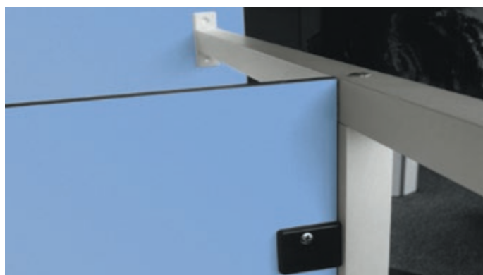
СОЕДИНЕНИЕ ПЕРЕГОРОДКИ СО СТОЙКОЙ ИЗ ПРОФИЛЬНОЙ ТРУБЫ
