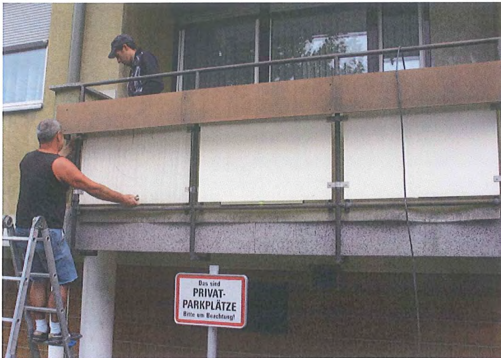
Abb. 2: links das alte Balkonelement „3“ sowie die bereits neu montierten Elemente
